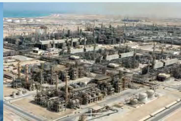
Qatargas 1 LNG trains
